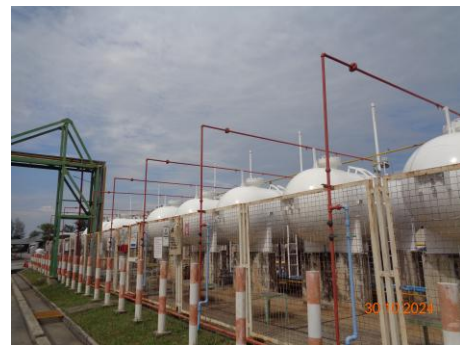
ภาพที่ 2.2-39 รั้วตาข่ายป้องกัน และเสาป้องกันการกระแทก บริเวณลานถังเก็บ LPG
