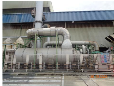
ภาพที่ 2.2-3 การติดตั้งเครื่อง EGF บริเวณเตาหลอม
