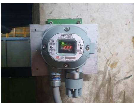
ภาพที่ 2.2-42 การติดตั้ง Gas Detector
