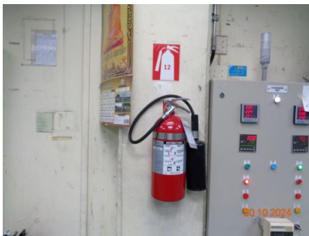
ถังดับเพลิงภายในอาคาร (Fire Extinguisher)
