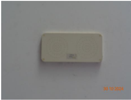
อุปกรณ์ตรวจจับความร้อน (Heat Detector)
