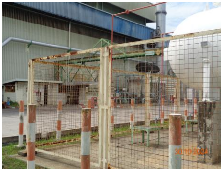
ภาพที่ 2.2-39 รั้วตาข่ายป้องกัน และเสาป้องกันการกระแทก บริเวณลานถังเก็บ LPG
